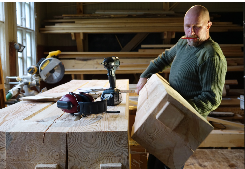
Timmerman Pierre Bosson arbetar med ramverkskonstruktionen. Pierre använder sina färdigheter som byggnadsvårdare för att både bevara och bygga nytt. Ramverkskonstruktionen kom att ta stor plats både i rummet och i tanken.
